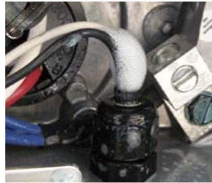
图7 泄漏通道可以存在于密封灯具内
